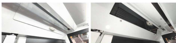
清掃用窓(閉まっている状態)
