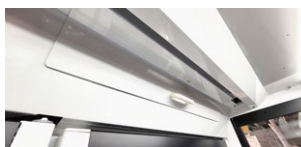
清掃用窓 (閉まっている状態)
