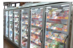
CO 2 冷媒の 冷凍リーチインショーケース
