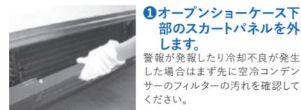
① オープンショーケース下部のスカートパネルを外します。警報が発報したり冷却不良が発生した場合はまず先に空冷コンデンサーのフィルターの汚れを確認してください。
