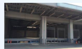
▲排水管を配置するために、床下にスペースを確保。工場の床は、トラックの荷台部分と同じ1mの高さに設定
