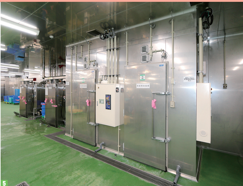
5 ブラストチラーは計6台。調理したものを直ちに冷却することで菌数を制御している／ 6 真空冷却機は3台。扉の取っ手にカウンタークロスを巻き付け、次亜塩素酸ナトリウムでぬらし、汚染源を抑えている／7 包装室。深絞り真空包装機。フィルムの上に定量の食材を載せて真空包装する／8 検品システム。バーコード検品を採用し、検品精度を向上させた。固定式スキャナーでバーコードを読み込み、施設ごとに全商品がそろっているかを確認。その様子はカメラで録画し、施設から問い合わせがあった際にはさかのぼって画像データをチェックし迅速に対応する
