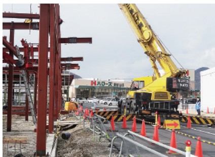
初夏までのオープン目指し、HC関連など、テナントの工事も急ピッチ
