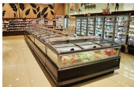
冷凍食品は蓋付平型と多段リーチインの冷ケースで省エネと品揃えアップを図る
