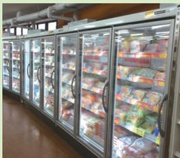
CO<sub>2</sub>冷媒の冷凍リーチイン
