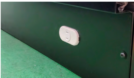
33 平型スカートコンセント
