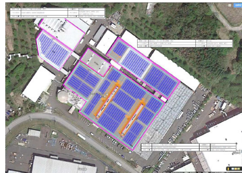
▲滋賀(水口)工場
