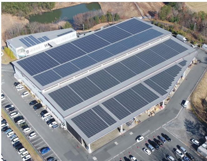
岡山第二工場完成写真
