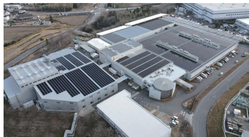
滋賀(水口)工場
