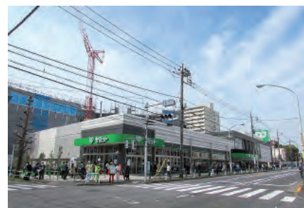
サミットストア世田谷船橋店。隣に 228 戸のマンションが建設中
