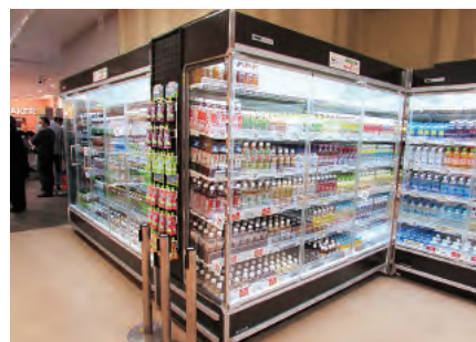
節電・省エネ対策から飲料冷ケースに扉を設置
