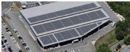
岡山第二工場
